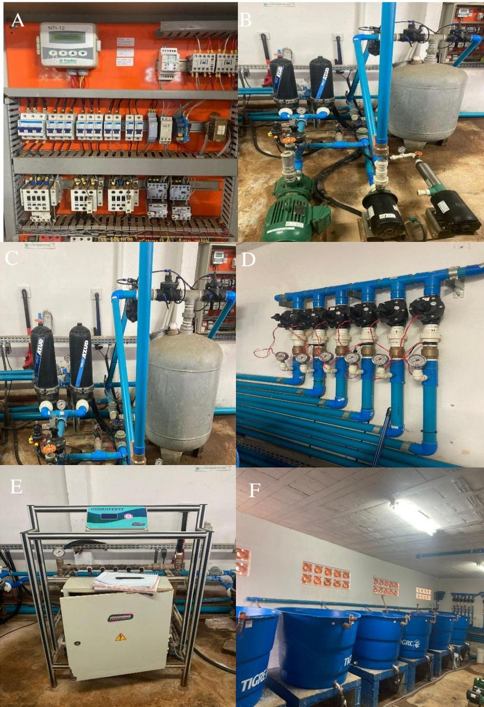
**Figura 4.** Timer de Irrigação NTI 12 (A); bomba de sucção e recalque (B); 2 filtros de disco, 1 filtro de disco de areia (C); válvulas com solenoide (D); injetor de EC (E); caixas de solução nutritiva (F).
