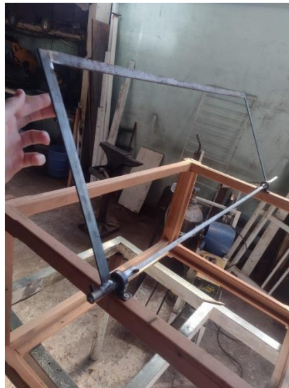
Figura 1: Início da construção da estrutura de madeira. Fonte: autoria própria.
